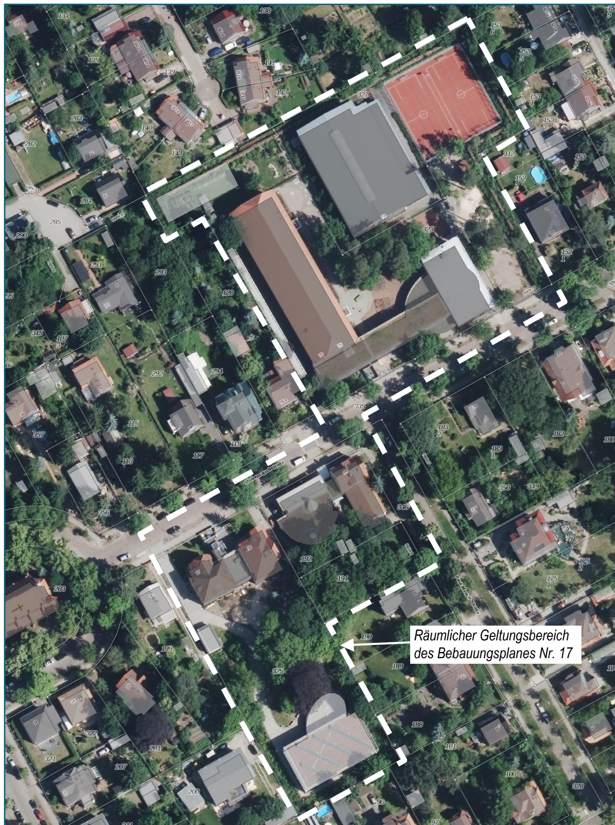
Abb. 2: Bestandssituation im Bereich des Bebauungsplanes Nr. 17
